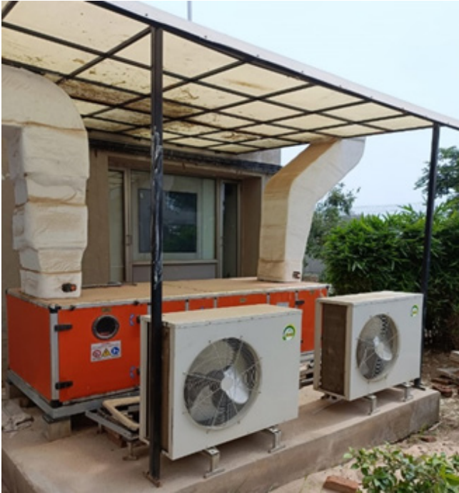
चित्र D.2: एफसीआईपीटी परिसर में एसआरपी लैब के लिए मौजूदा 10000 क्लास के स्वच्छ कमरे के लिए प्रत्यक्ष विस्तार एयर हैंडलिंग इकाई और एयर कंडीशनिंग प्रणाली है।
